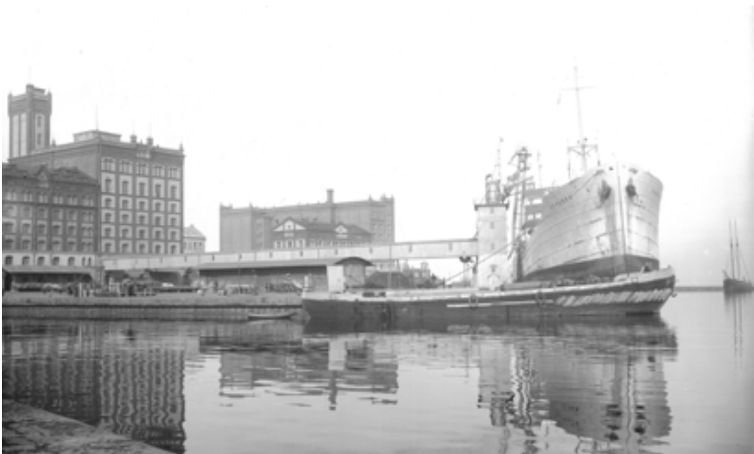
Elevatorkajen med ett spannmålsfartyg under lossning
